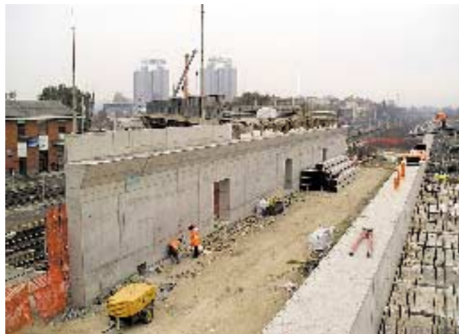
Torino. Lavori sull'autostrada per Milano alle Basse di Stura
